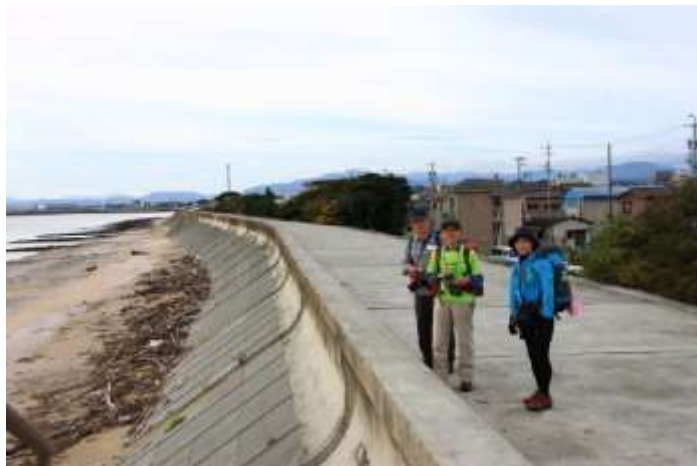
堤防上の通路(道路ではない)は車が通り油断できない
