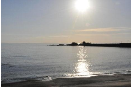
鈴島・孔島へ続く堰堤
