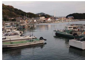
下津井亭から瀬戸大橋を望む
