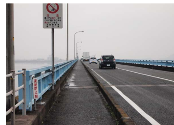
水島大橋西詰より水島方面
