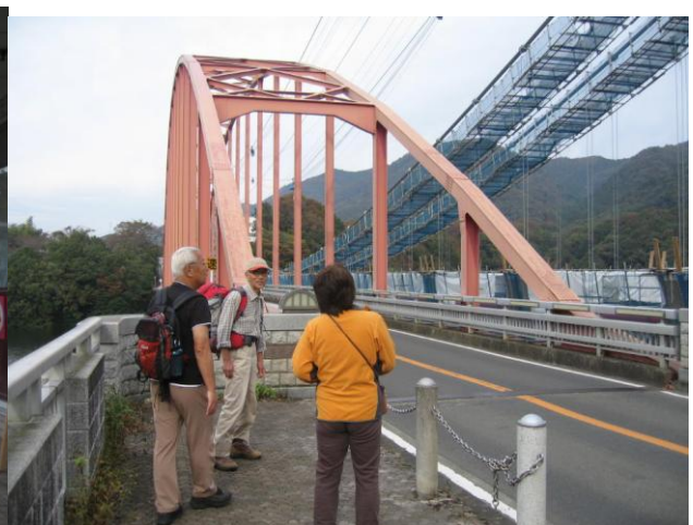
三井大橋 歩行者用の立派なつり橋を建設中
