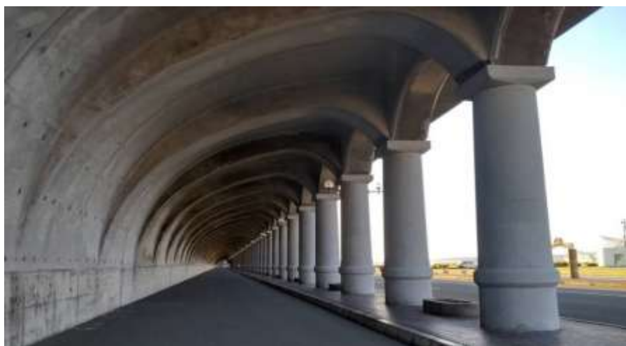
朝食前の散策にて 稚内港北防波堤ドーム
