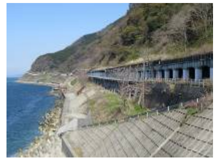
洞門を完了した地点より振り返る
