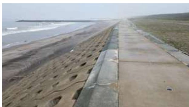
平成 27 年度築の堤防上を歩く
