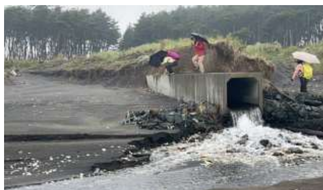
導水管の上を越えて
